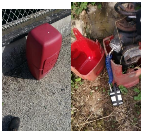
Figure 4 : Poteau équipé d'un enregistreur
