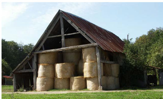
« La seconde vie d'un bâtiment traditionnel à Isigny-le-Buat (Manche) », cliché de Philippe Madeline, octobre 2006
