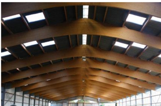
Charpente lamellé collé
