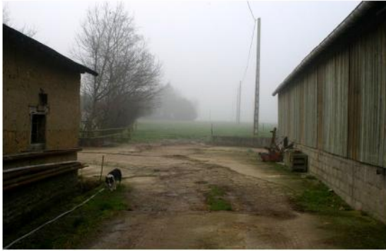
Bâtiment ancien et récent
