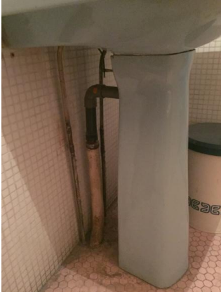
Figure 27 : Photo du lavabo situé au deuxième étage
