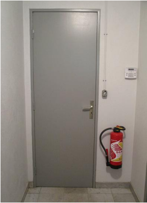
Figure 15 : Photo d'un mur prise au rez-de-chaussée
