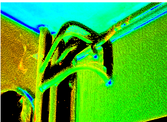
Figure 22 : Capture d'écran du nuage de points représentant des canalisations au niveau du premier étage
