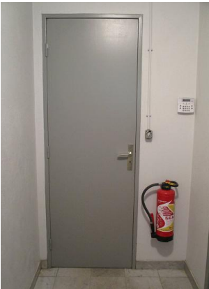
Figure 15 : Photo d'un mur prise au rez-de-chaussée
