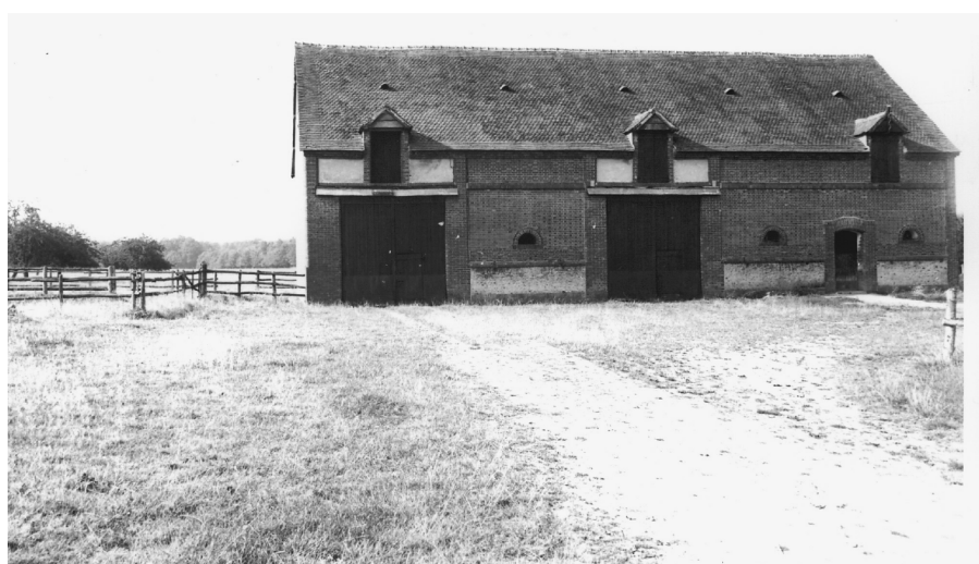
Remise grange- étable : façade antérieure.
