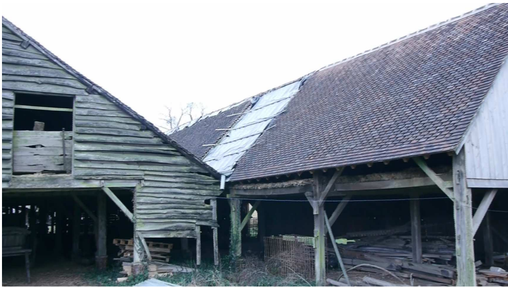
Bâtiments de la Tuilerie des Saules, vue du Nord.
