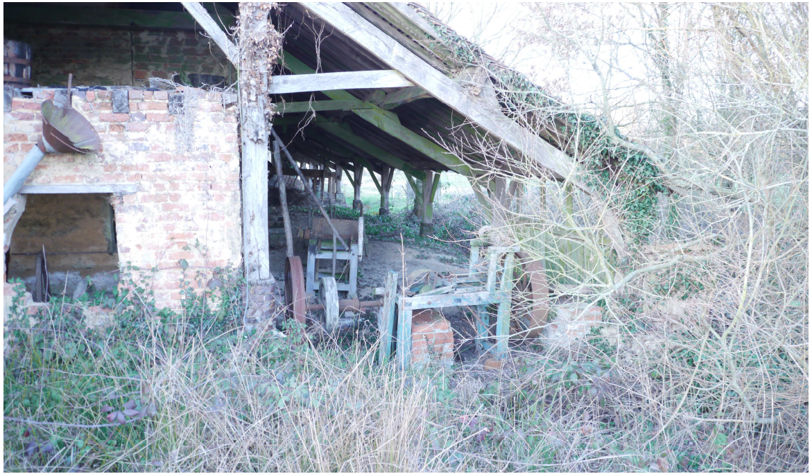
Ancien emplacement de la scierie
