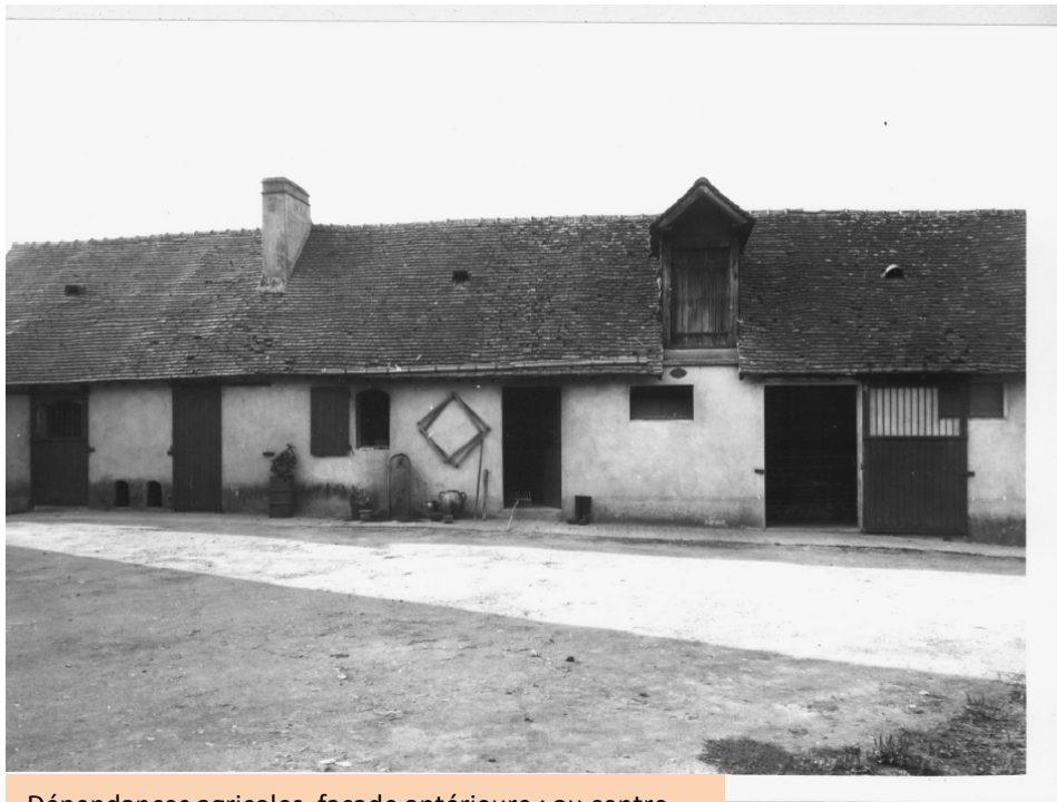
Dépendances agricoles, façade antérieure : au centre ancien logis, vers 1960
