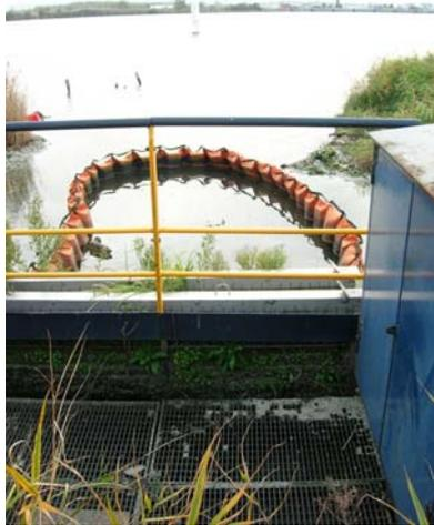
*Figure 20: Filtre drainant des eaux de surface*
