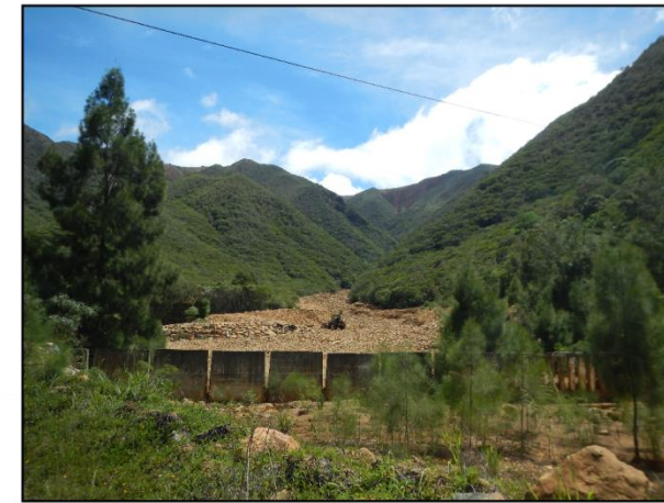
c : Creek cimetière et ouvrage en peigne pour bloquer les sédiments
