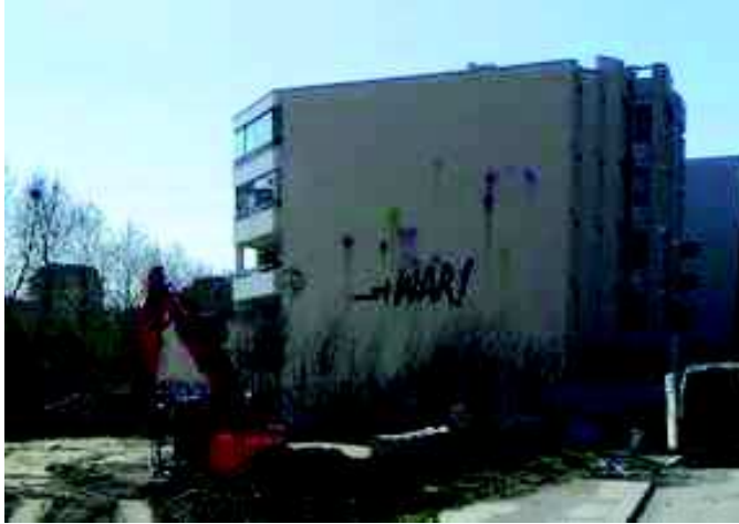
Illustration 20 : La façade Est en début de construction (Fox35, 2012)
