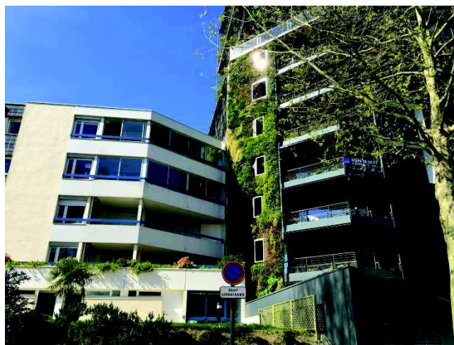
Illustration 19 : Le coin litigieux après construction
