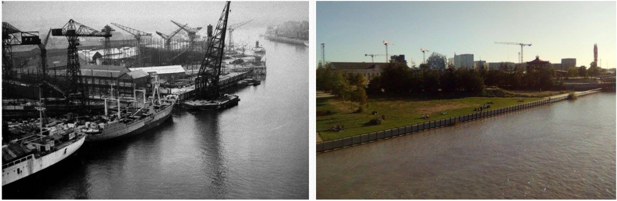
A gauche, les Ateliers et Chantiers de Bretagne et Ateliers et Chantiers de la Loire en 1953 [Source : Maison des Hommes et des Techniques]. A droite l'île de Nantes en 2017. Les grues de construction d'entreprises de BTP ont remplacées celles de la construction navale. D'autres grues de promoteurs planent au même moment au dessus de l'ancienne Bourse du Travail
