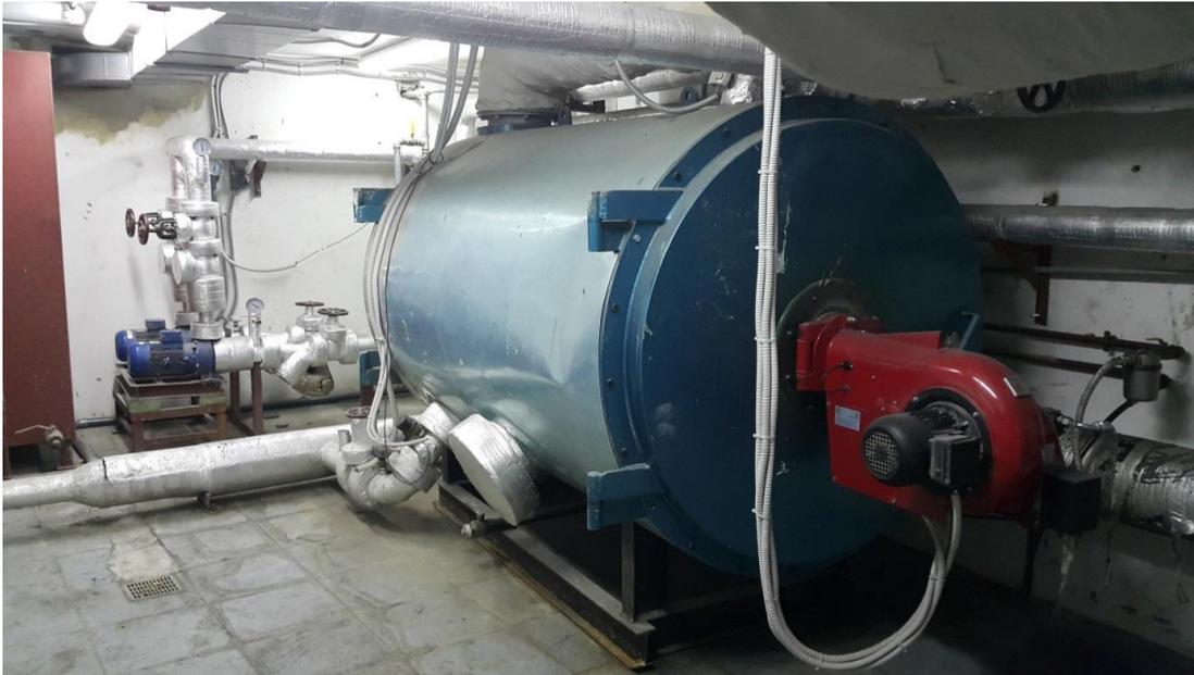
Figure 7: Vue extérieure d'une chaudière installée dans 'Arizona Gym'.
