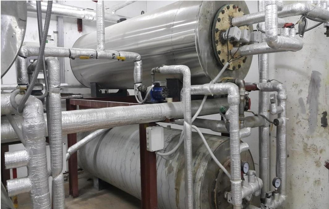
Figure 6: Vue extérieure de deux réservoirs d'eau chaude, installés dans 'Arizona Gym'.
