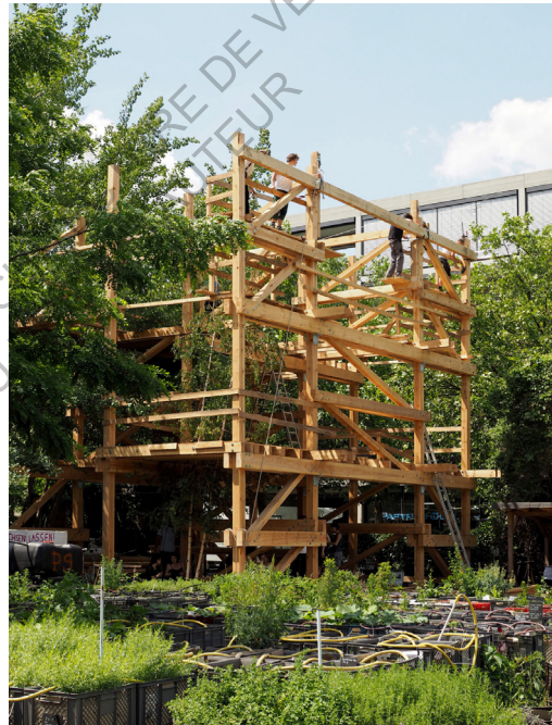
e : La structure en cours de construction
