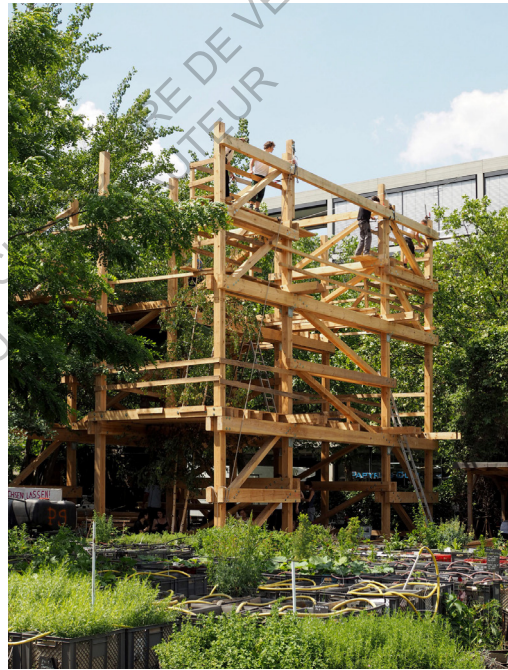
e : La structure en cours de construction
