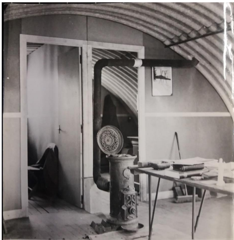
ANMdt 2010 018 343, Vue intérieure d'un igloo, date et auteur inconnus.
