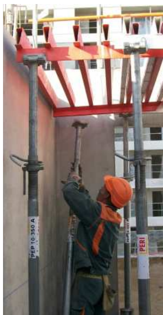
A 9h32 le compagnon 1 met en place un étai
