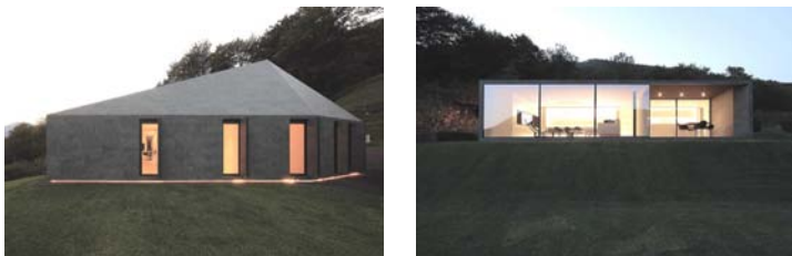
Montebar Villa JMA Architectes, Medeglia, Suisse, 2015 © Jacopo Mascheroni
