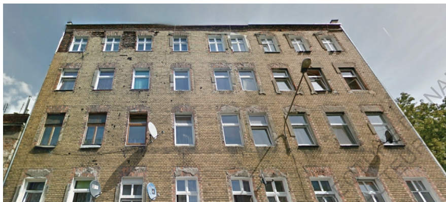
Fig. 24 Photo d'un bâtiment d'habitation de la rue Rydygiera
