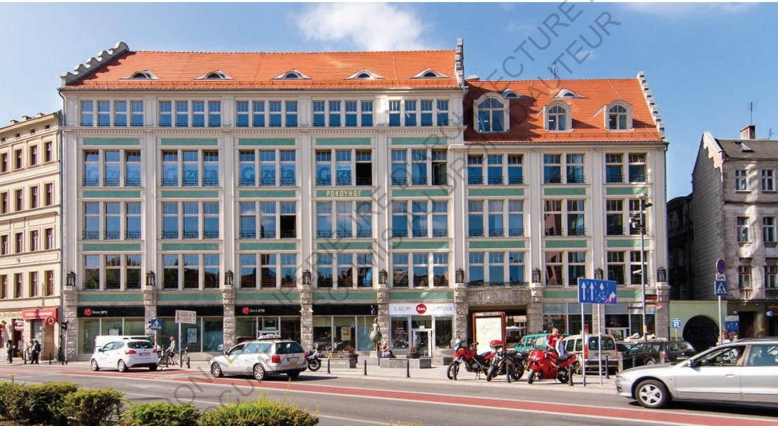
Fig. 32 Photo de la façade du bâtiment Pokoyhof
