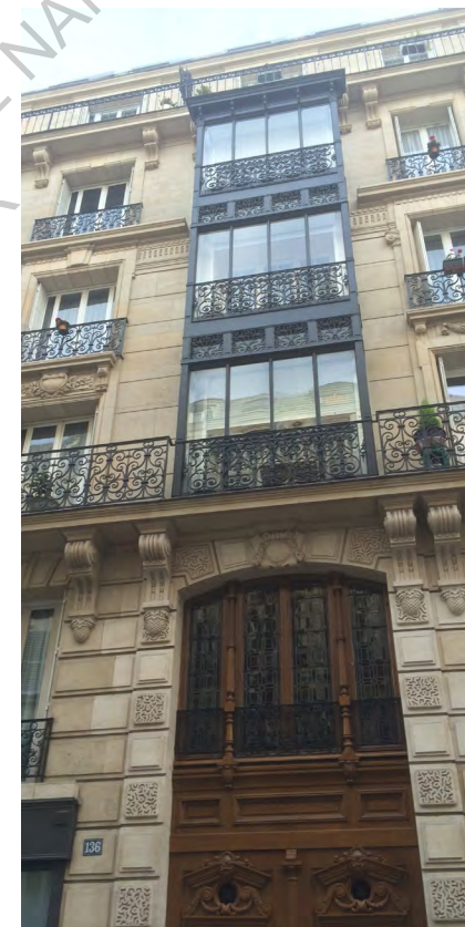
Fig 46 & 47. Immeuble de la rue Georges Berger & Immeuble de la rue Legendre après l'avenue de Clichy
