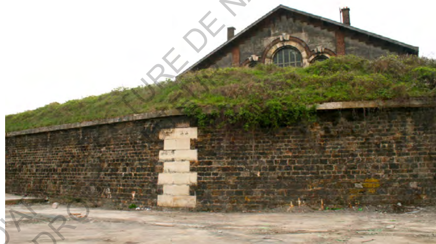
Fig 9. Vestige des fortifications de Thiers - Bastion 44
