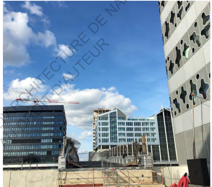
Fig 117 La passerelle reliant les deux rives de la ZAC en construction
