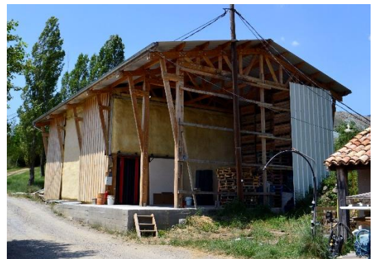
Figure 34 - Frigo à pomme en éco-construction bois-paille-chaux, Barillonnette (05)- Source : Claire MASQUELIER, 2017
