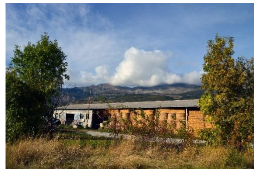
Abbildung 11 - Schuppen aus Beton mit Stahlstruktur, Chorges (05) - Quelle: Claire MASQUELIER, 2017
