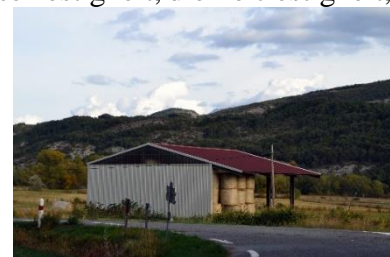
Abbildung 12 – Schuppen. Stahlstruktur und Stahlblech Fassadenverkleidung, Montgardin (05) – Quelle: Claire MASQUELIER, 2017
