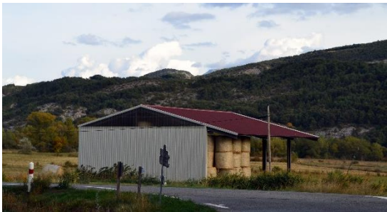
Figure 34 - Hangar à fourrage, structure, bardage et toiture métallique, Montgardin (05) Source : Claire MASQUELIER, 2017
