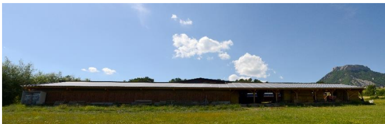
Figure 27 - Bâtiment double (bergerie et hangar à fourrage et matériel (4 et 6)) construit en 2016, Vitrolles (05) – Source : Claire MASQUELIER, 2017
