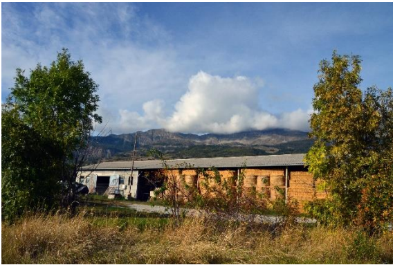
Figure 35 - Hangar, structure métallique et béton, Chorges (05) - Source : Claire MASQUELIER, 2017
