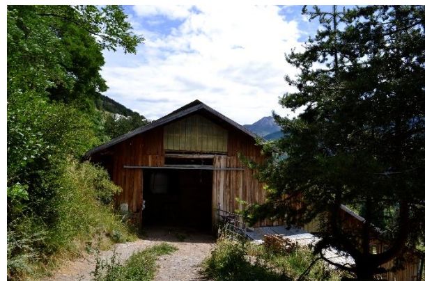
Figure 47 - Bâtiment construit dans la pente, Chateau-Vieille-Vieille (05) - Source : Claire MASQUELIER, 2017
