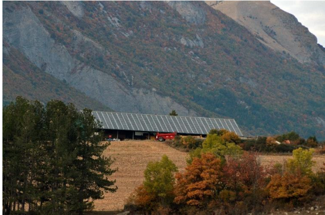
Figure 30 - Bâtiment agricole avec toiture photovoltaïque, La Freissinouse (05) - Source : Claire MASQUELIER, 2017
