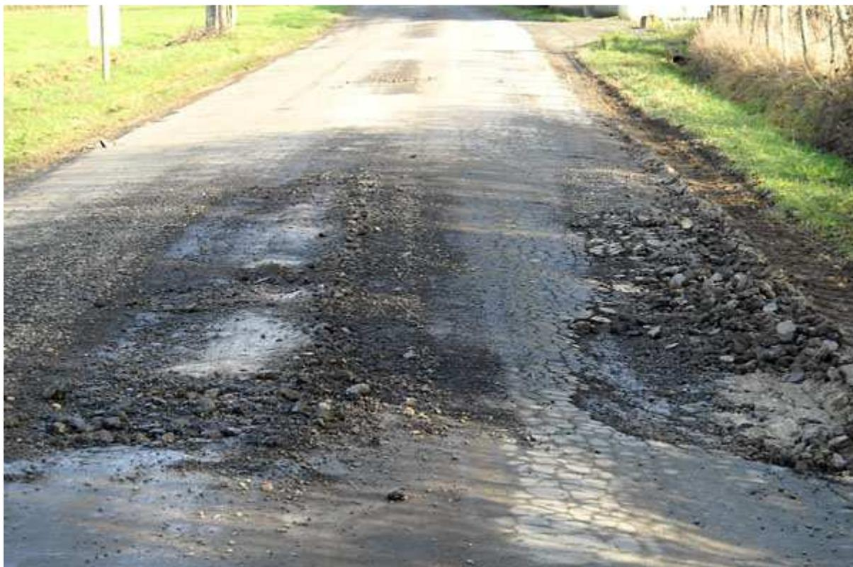
*Figure 21 : Effets de la circulation sur une chaussée à la suite d'un phénomène de succion cryogénique (Source : Conseil Départemental des Deux-Sèvres)*
