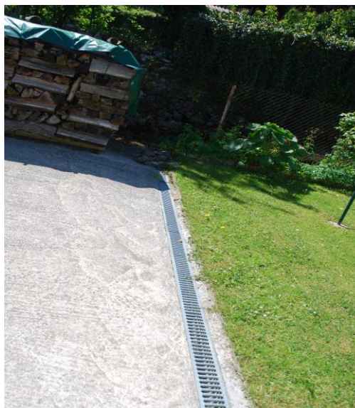
Figure 14 : Photo de la venelle permettant de ramener l'eau dans le ruisseau canalisé. Prise par P. Malfondet le 28/4/17
