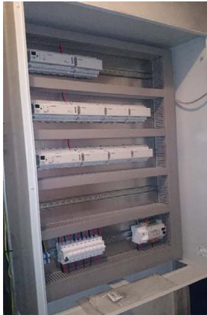
Figure V-7 : Un tableau assemblé dans un coffret
