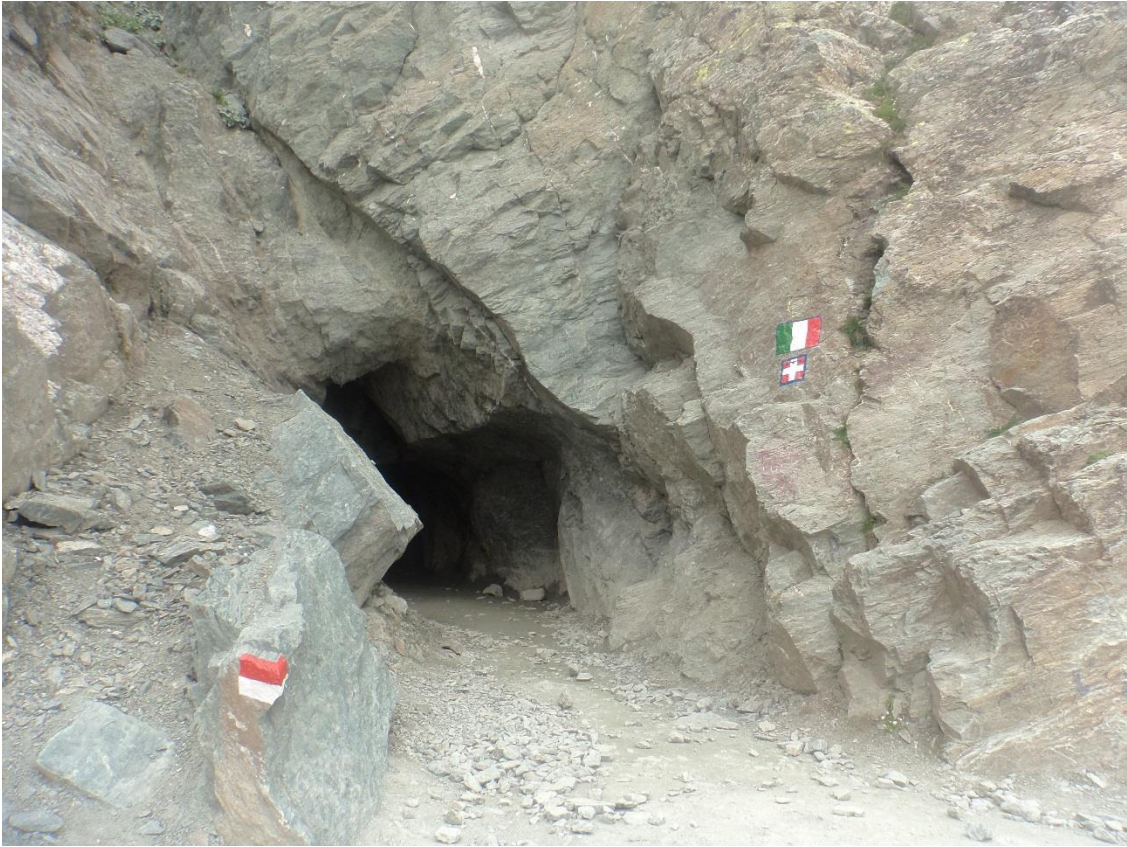
Figure 27: L'entrée du Tunnel du Viso côté italien aujourd'hui
