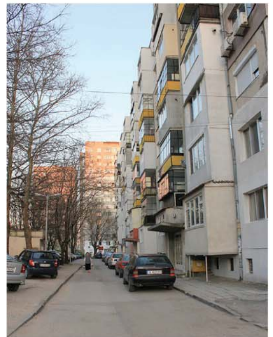
Façade nord de la barre 75
