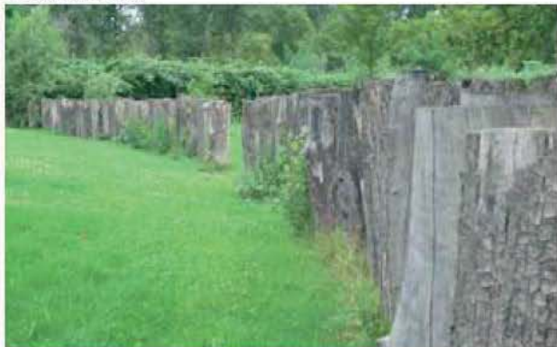
Des pieux de bois comme "clôture"
