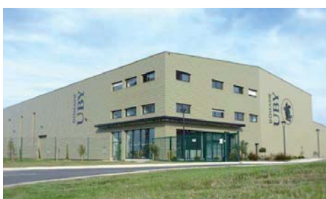
Vue extérieure sur le chai
