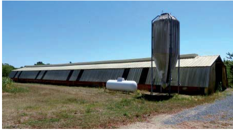
Vue sur le bâtiment
