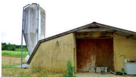
Vue sur l'entrée du bâtiment et l'accès au SAS d'hygiène
