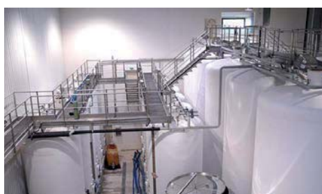
Vue sur les cuves
