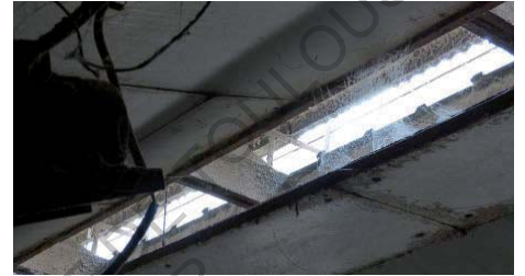
Vue sur les ouvertures en toiture
