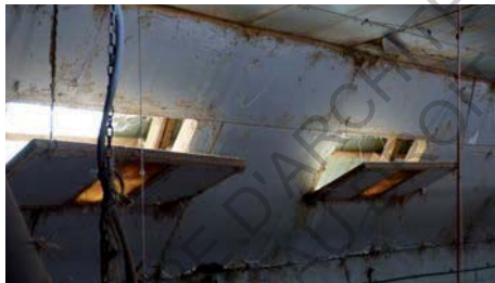
Vue sur les ouvertures murales pour la ventilation
