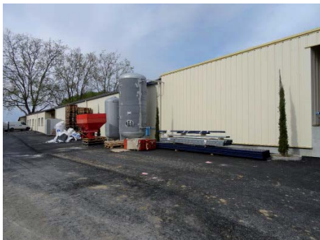
Vue de la partie arrière du chai (photo personnelle, mars 2015)
