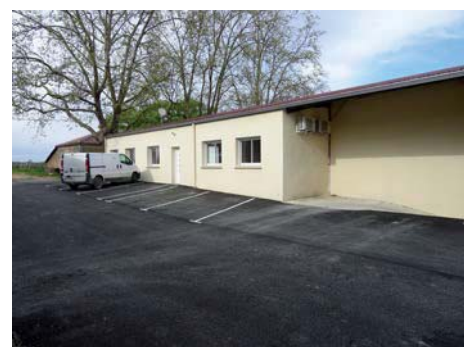
Vue sur l'arrière du chai - Entrée de service
