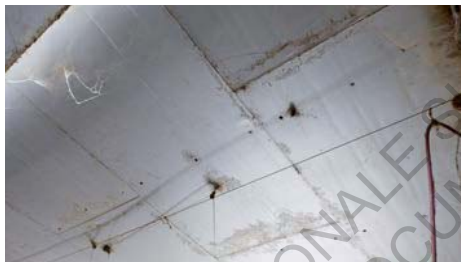
Vue sur la toiture (côté intérieur en panneaux sandwich)
