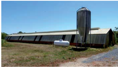
Vue extérieure du bâtiment
