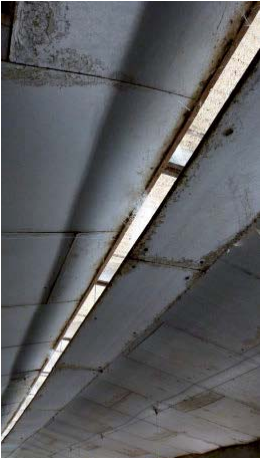
Vue sur les ouvertures murales pour la ventilation
