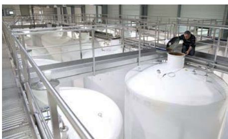
Vue sur les cuves
