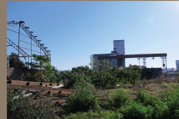
Photographie: Lieu délaissé au niveau de la deuxième digue (Hotel en fond) Juin 2014
