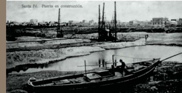
Carte Postale de Santa Fe, représentant le port en construction
