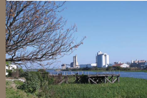
Photographie: Ancien pont d'accès inutilisé
