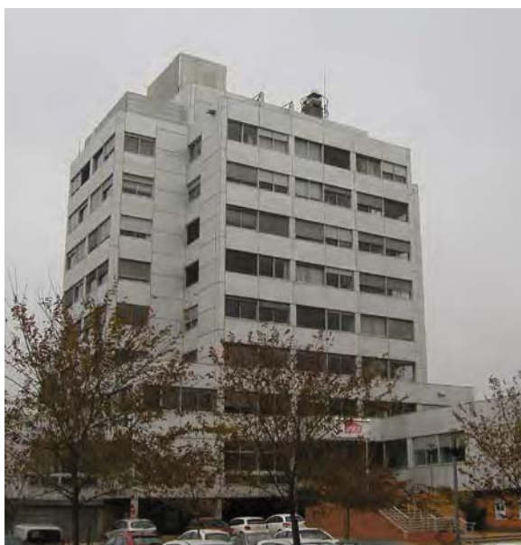
Bureaux de la SNCF à Matabiau.
