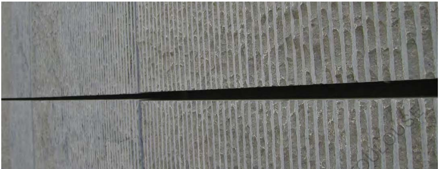
15 rue Alexandre - Bida, 2009, détail du parement du rez-de-chaussée.
