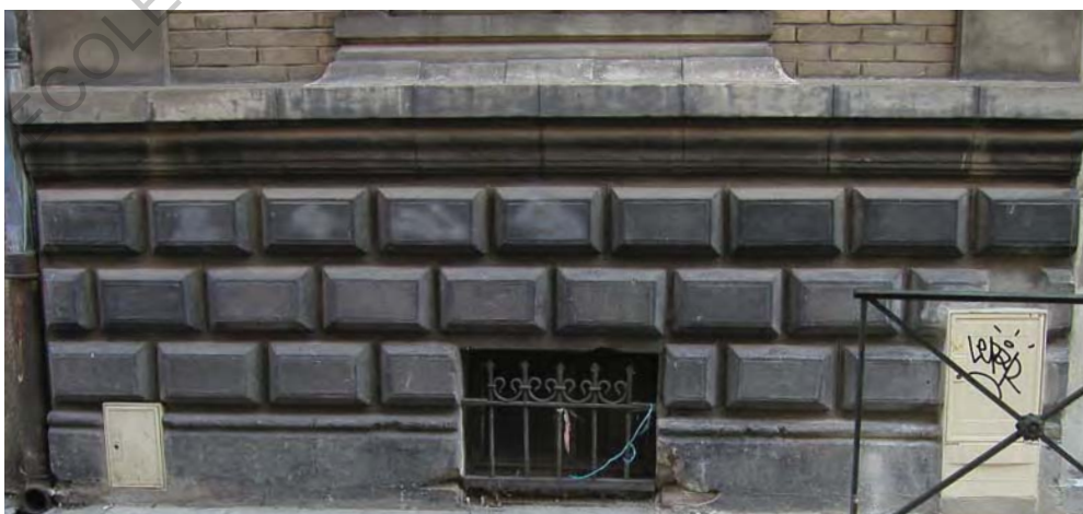
34 rue Sainte Marthe, détail du soubassement.
