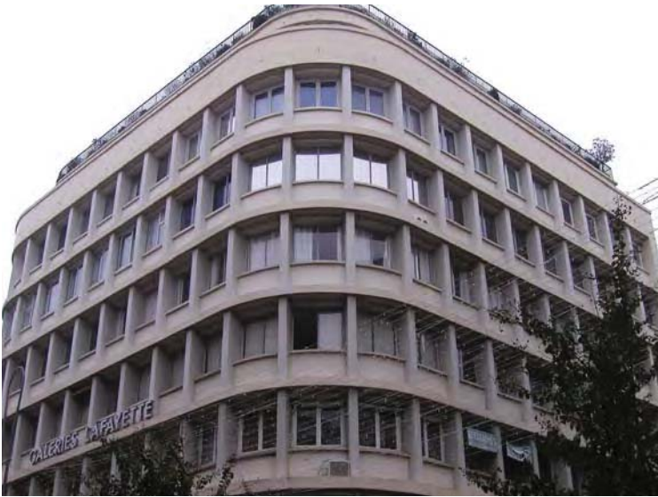
Immeuble de bureaux, 24 rue Alsace Lorraine, 1958, Alet Georges.
