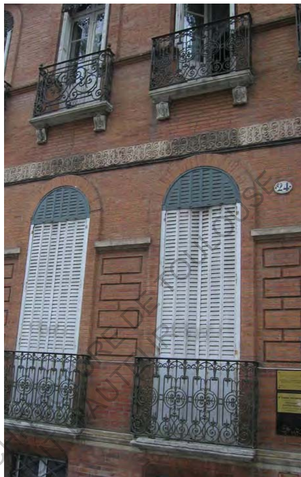
Immeuble du 24 boulevard d'Arcole, deuxième moitié du XIX e siècle.
