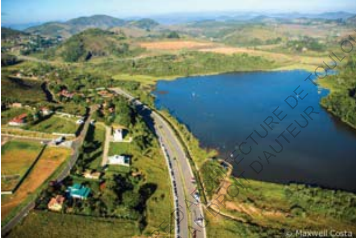
Image 33 : Vue aérienne de la première partie de la route
