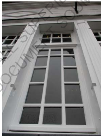
Figure 28 : Emboue pour Tenir les volets amovibles
