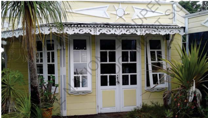
Figure 63 : Ornementation plaqué en façade, Case Marion
