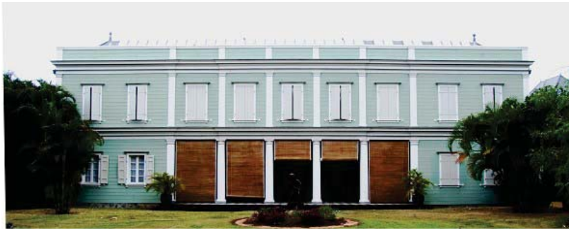
Figure 2 : Villa Dérramond Barre, Saint-Denis
