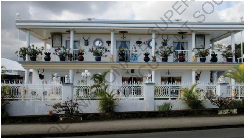
Figure 38 : Photo d'une case malbar avec les différentes protections visible en façade
