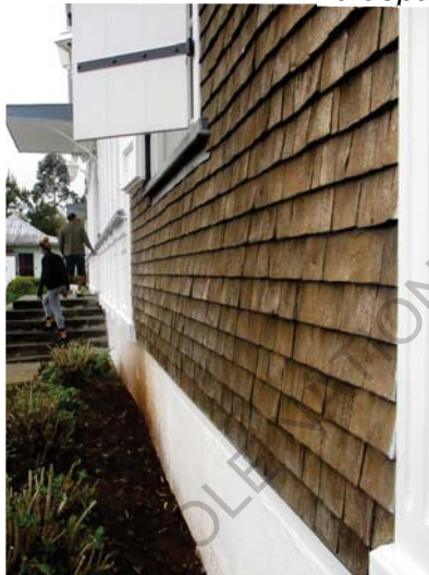
Figure 27 : Revêtement en bardage en bois de Tamarin
