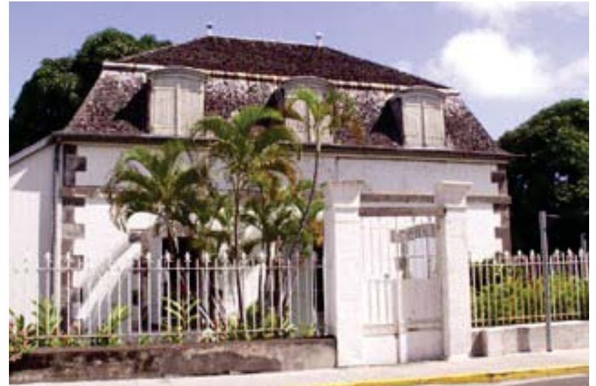
Figure 80 : Clôture de la maison Adam de Villiers, Saint-Pierre
