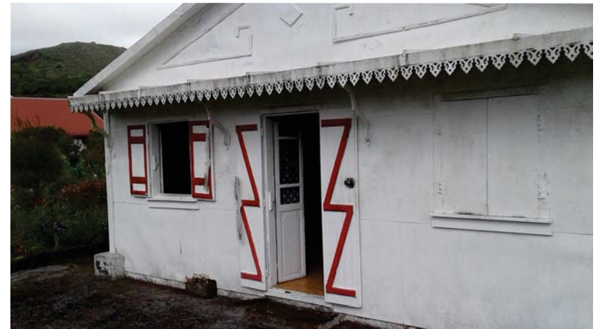
Figure 61 : Lambrequins en tôle sur l'auvent de la Case Grondin
