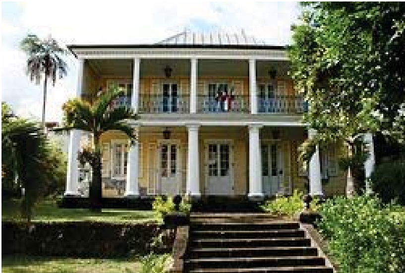
Figure 22 : Photo de la maison Motais de Narbonne Source : www.fr.wikipédia.org
