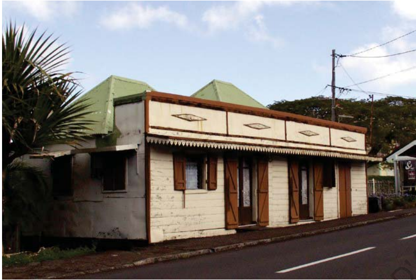
Figure 29 : Photo d'une case créole à Saint-Philippe
