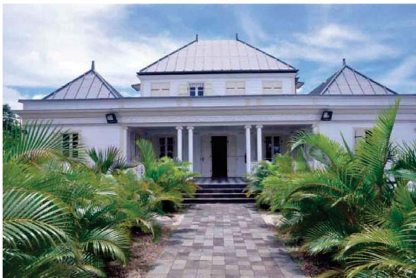
Figure 64 : Photo de la maison Foucq, Saint-Denis Source : www.habiter-la-reunion.re
