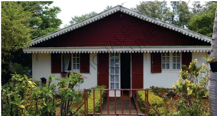
Figure 49 : Mélange de revêtement en bardeaux et en tôles Photo de la Case Grondin
