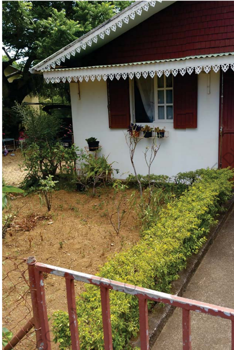
Figure 72 : Clôture et portail de la Case Grondin, ils sont bien présents mais discrets
