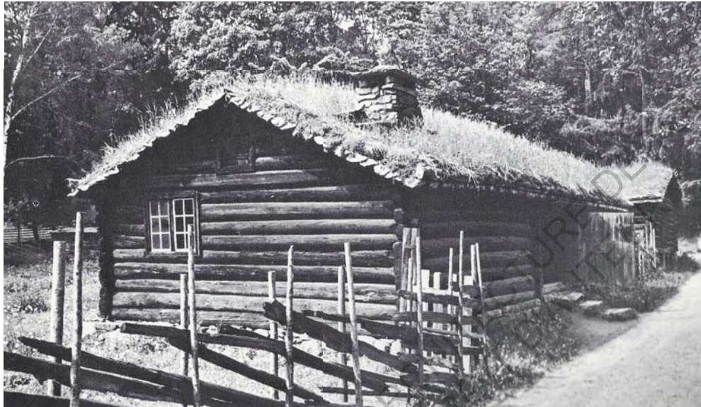
La maison en rondin finlandaise, en Laponte. Ici, le toit est recouvert de terre et de gazon pour une meilleur inertie thermique. Source : Maison de bois, Architecture Scandinaves, Thérèse et Jean Marie bresson
