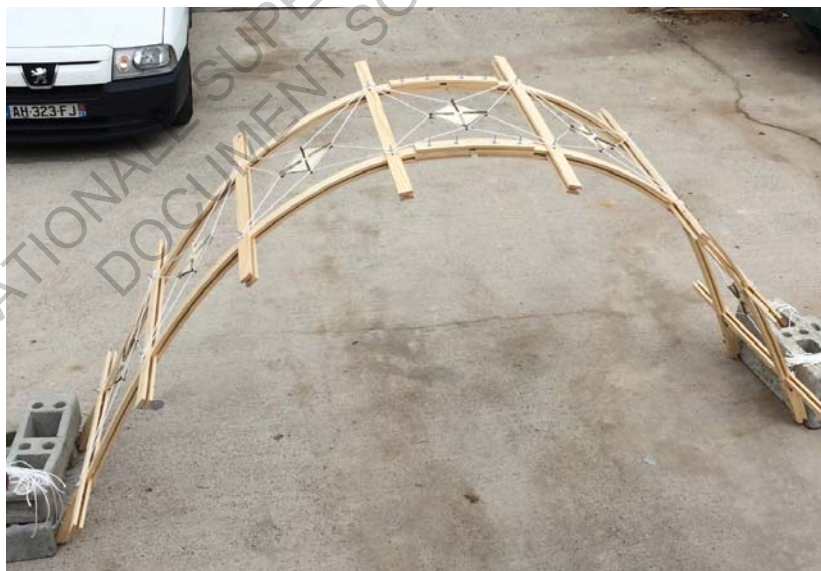
2. La grille est ensuite poussée pour obtenir sa forme finale. Chaque nœud est ensuite bloqué, puis les cordes de contreventement sont mises en tension. La structure est stable et rigide. Illustration : mathieu sudres
