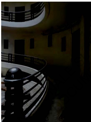
Photo 11: Début de la rampe (rdc)
