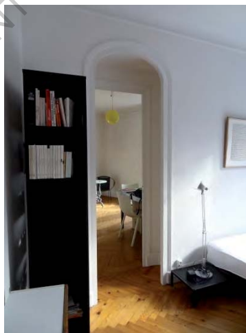
Photo 19: Cloison épaisse entre chambre 2 et salle à manger (T3)
