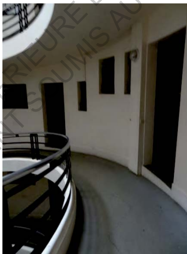
Photo 12: Montée de la rampe (étage)
