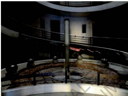
Photo 26 : départ du feu au rdc
