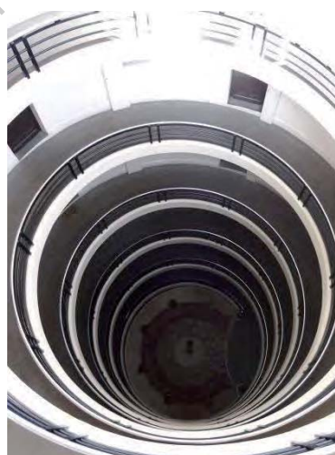
Photo 10: Cour intérieure depuis les étages - Lampadaire central
