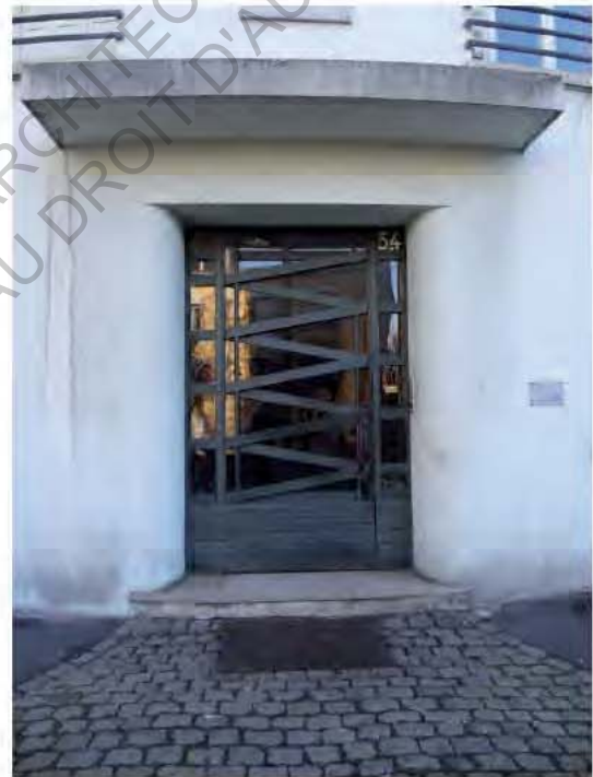
Photo 5: Porte d'entrée de l'immeuble
