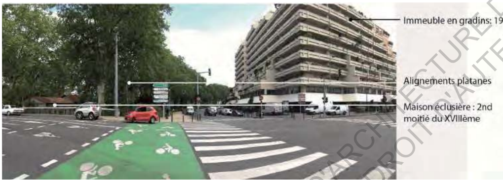
FIGURE 39. PONT MATABIAU, PRISE DE VUE ORIENTEE VERS BOULEVARD MATABIAU, 2016. (SOURCE PERSONNELLE)
