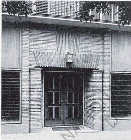
Portada compuesta con ladrilletas y ladrillos y balcón corrido, de hierro, en fachada. Casa núm. 61 en la calle Meléndez Valdés.
