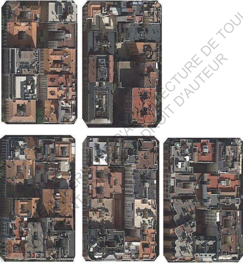
Ilots actuels surpeuplé, quartier Salamanca, vue aérienne Madrid, source : google earth
