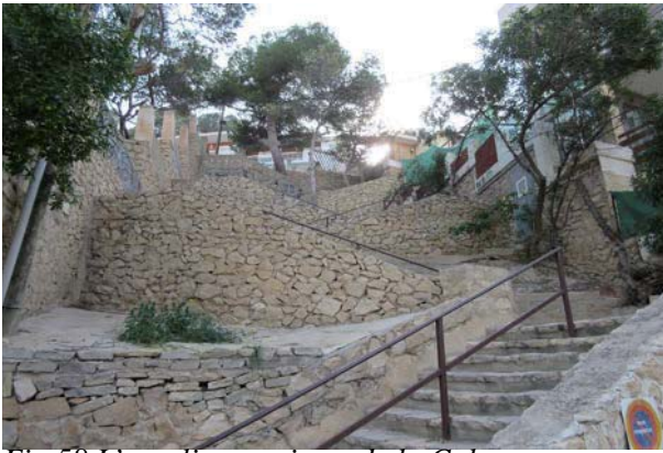
Fig.58 L'escalier en pierre de la Cala
