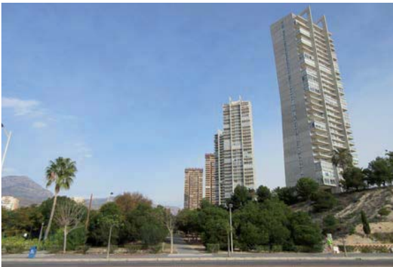
Fig.71 Gratte-ciels surplombant le chemin piéton
