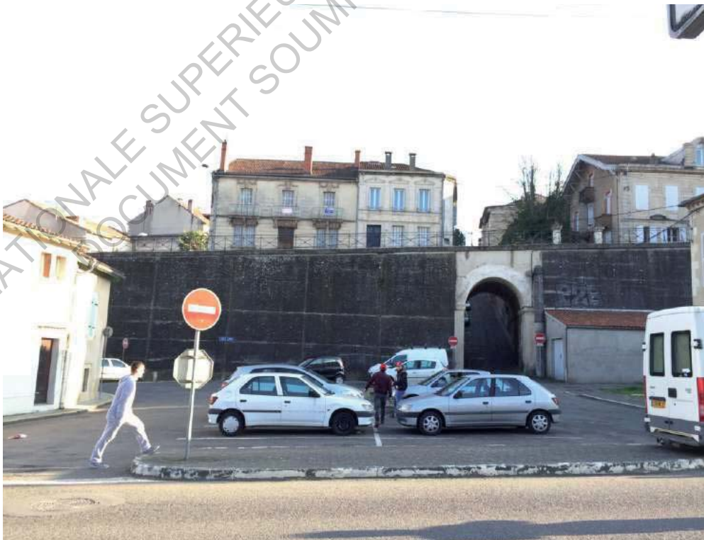
Prolongement de la rampe réalisée au XIX ème siècle avec le nouveau tracé de la route royale de Toulouse à Bayonne. Un pont est réalisé sous la rampe pour la rue Pagodéoutes.
