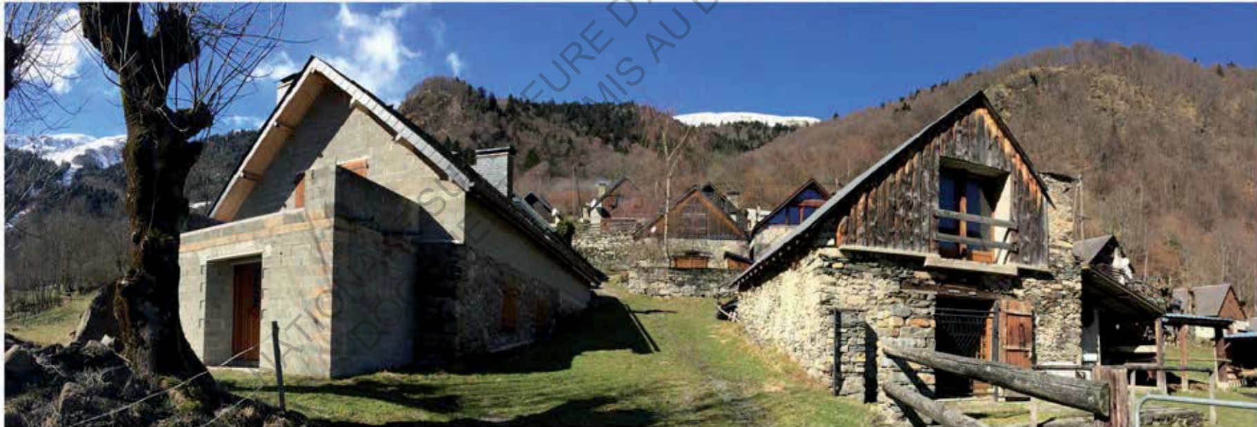
Illustration 18 : Construction en cours à Gouron, mars 2016
