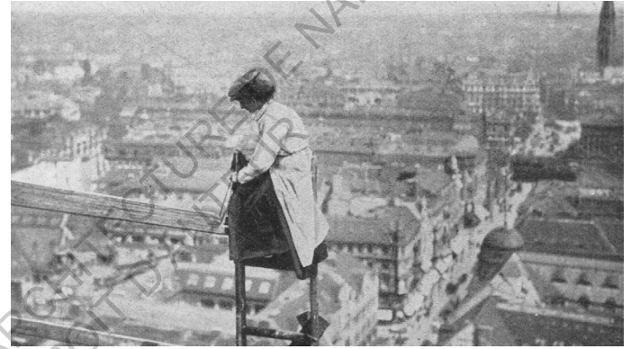
Eh hommage à Fay Kellog à New York, une femme constructeur à Berlin montre son audace à la presse. Elle est photographiée faisant des réparations sur le toit de l'hôtel de ville de Berlin en 1910. Illustrierte Frauenzeitung 38, fro
