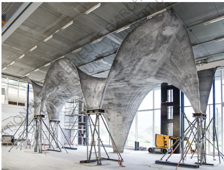
fig.26 ETH Zurich, expérimentation sur des voiles de béton armé.
