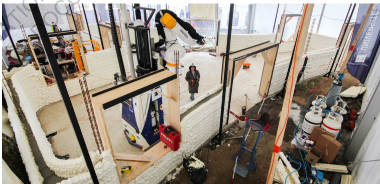
fig.38 Le robot remplit les espaces prévus entre les réservations en bois.
