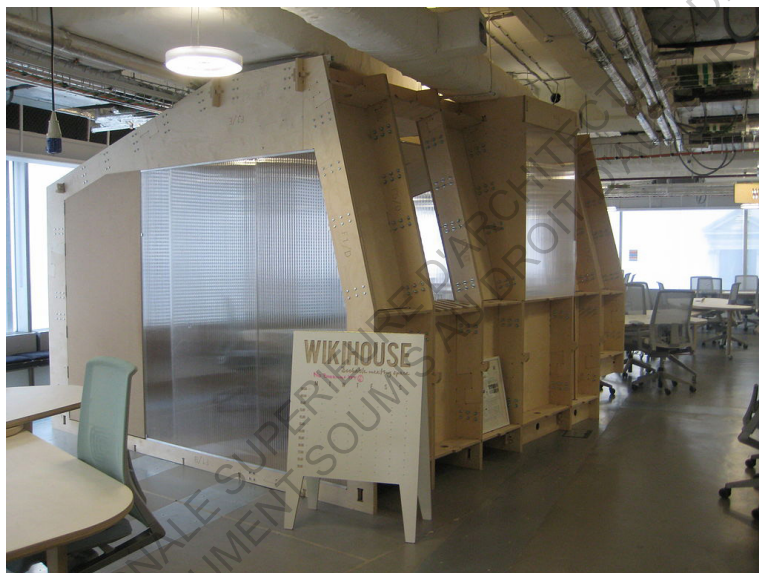
fig.17 Prototype de maison WikiHouse, découpée avec une CNC.
