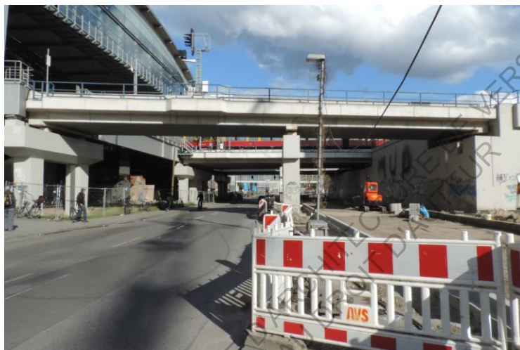
Figure 24 – Ostkreuz, Dimanche, 17h. La gare en continué chantier conserve tout de même un passage pour la traverser.
