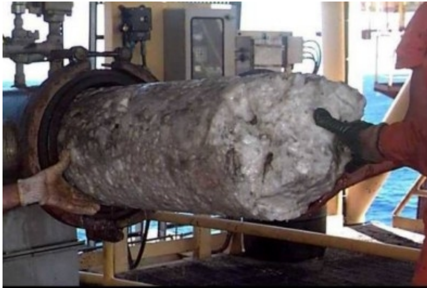
FIGURE 2.4 – Bloc d'hydrates accumulé dans un tuyau
