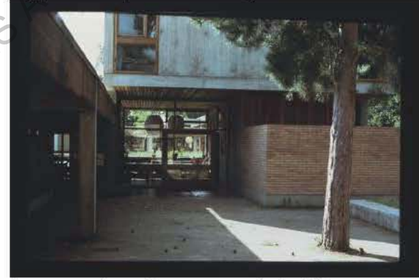
La cours et la partie commune de l'unité
