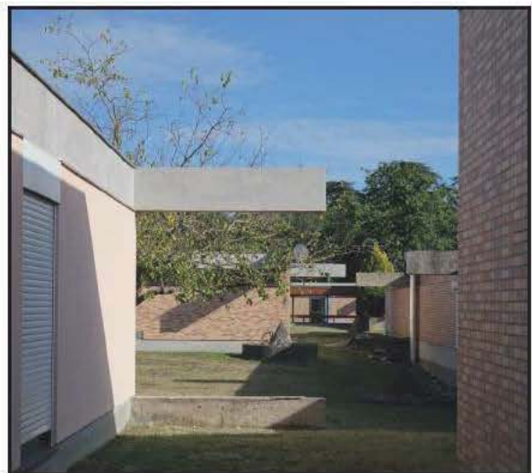
Vue sur les éléments de brique qui se décalent et limitent le regard
