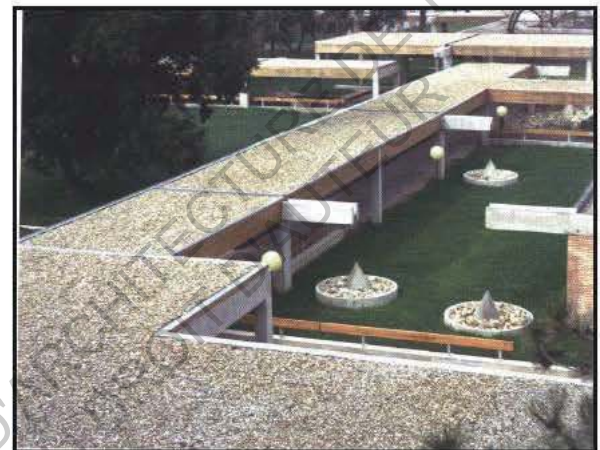
Gargouille, cône et bac galets
