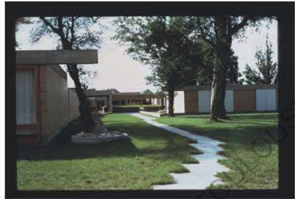
Perception des éléments en brique et béton qui structurent le paysage
