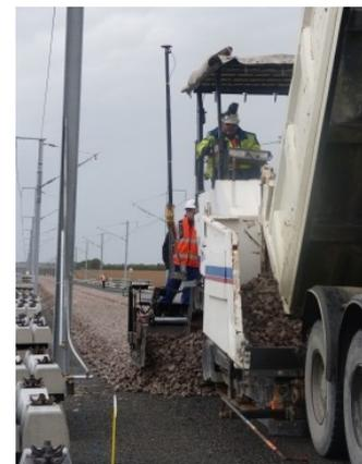
Figure 14: Mise en œuvre ballast
