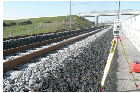
Figure 18 : Station positionnée avant levé – LGV SEA (source C Bury)
