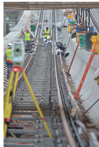
Figure 5 : Chantier Ferroviaire - Mire (Source MIRE S.A.S)
