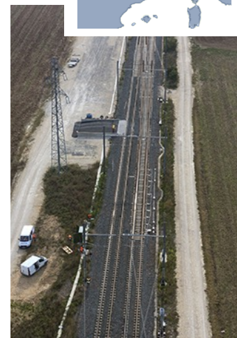
Figure 13: Opération LGV-SEA (source : site « Travaux LGV-SEA »)
