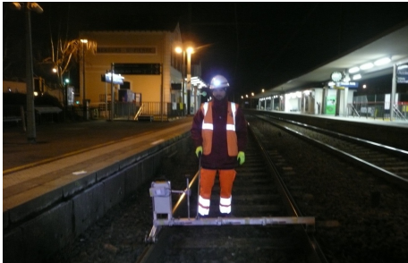
Figure 12 : Relevé des quais de gare (source C Bury)
