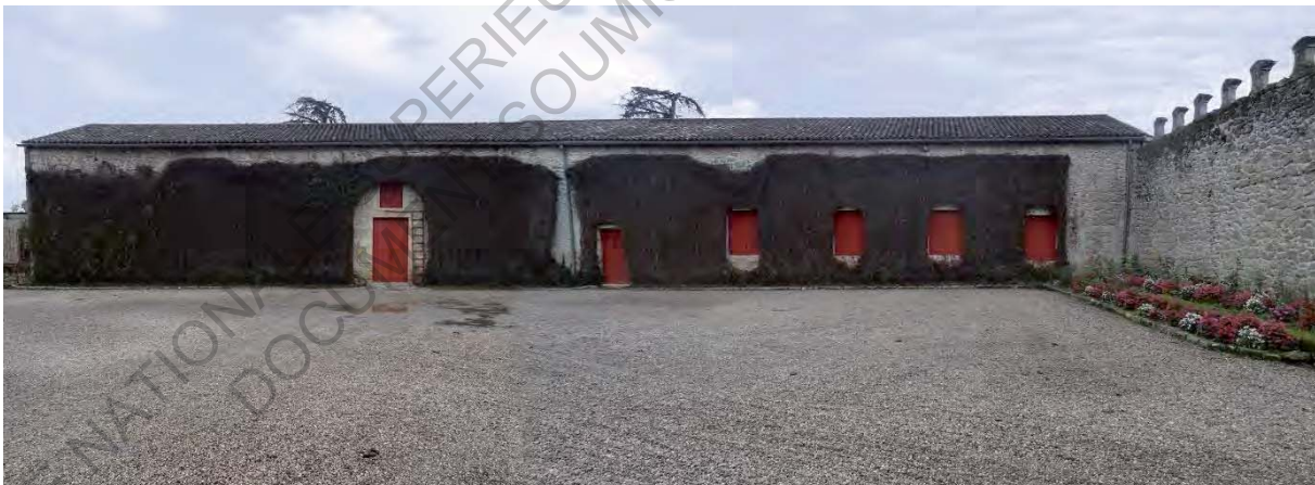
Chai sud-est / Façade sur cour / Photographie avec la végétation
