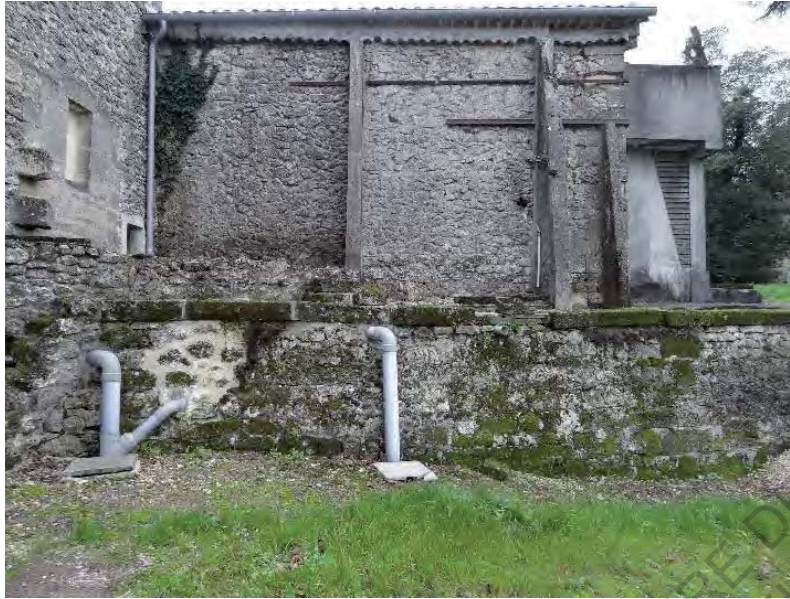
Photographie de l'arrière du chai sud-est
