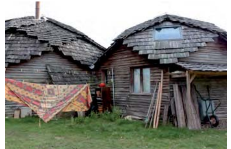
Photos des équipements extérieurs prises le 19/03/2016
