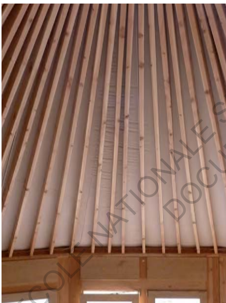
Photos prises le 12/11/2015 [Pieu / Rangements sous yourte / Chambre / Chevrons]
