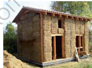
Maison de paille en construction
