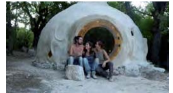
Chantier / 21 ème jour
