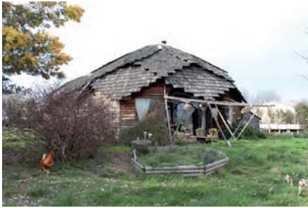
Photos des façades prises le 19/03/2016
