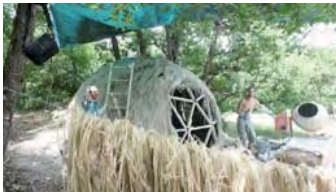
Chantier / 4 ème jour
