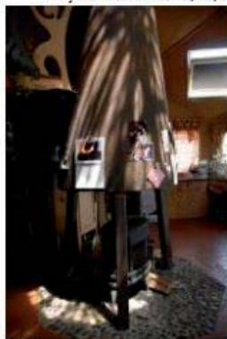
Le poêle à conduit apparent (AARP 2014)
