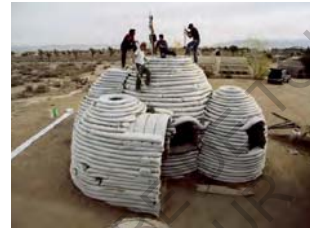
Eco-dôme en construction
