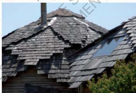
Détail des toitures en bois (AARP 2014)
