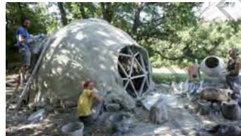
Chantier / 10 ème jour
