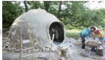
Chantier / 12 ème jour
