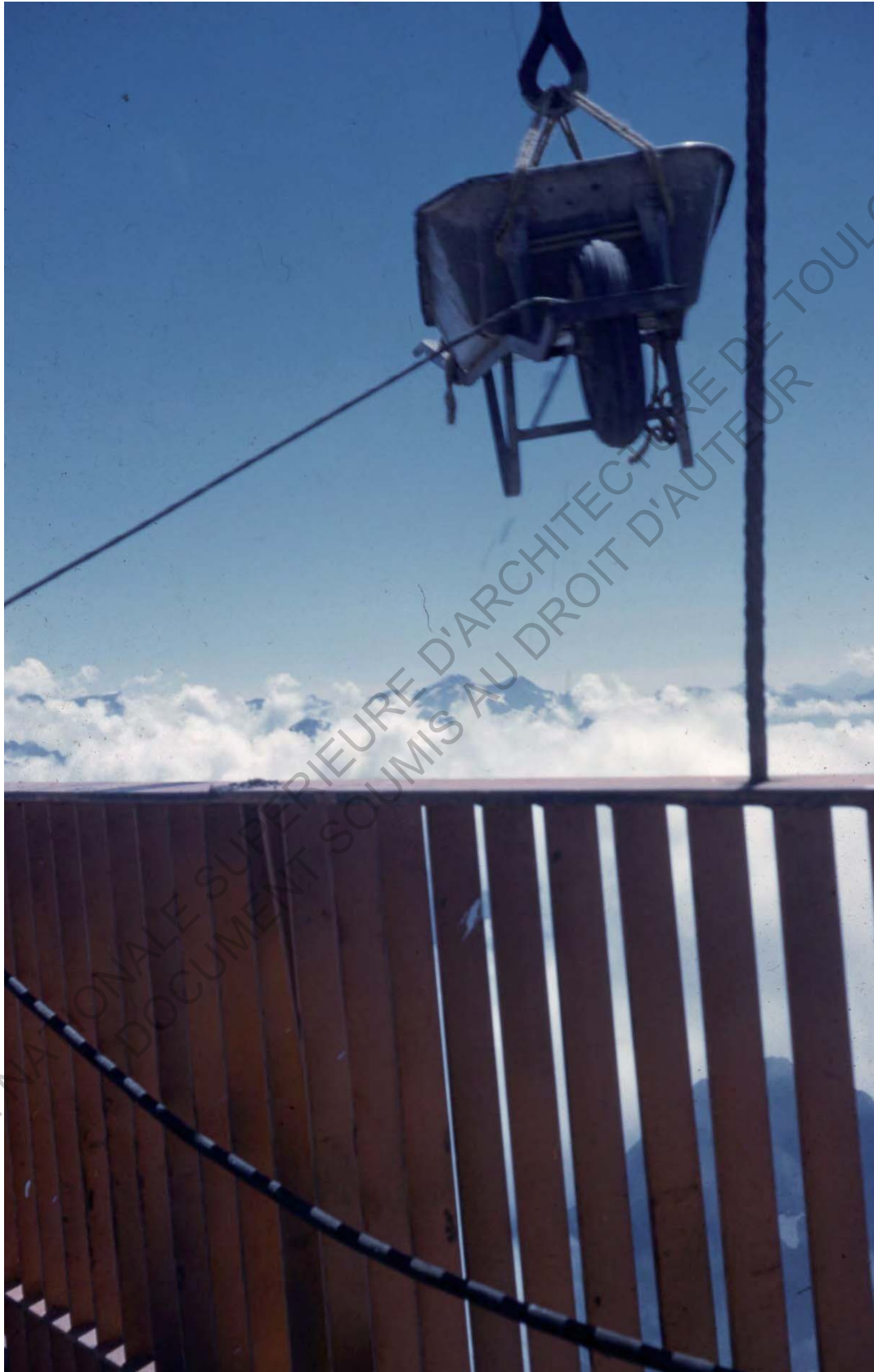
Photographie du chantier du Bâtiment Interministériel du Pic du Midi de Bigorre Pierre Debeaux - été 1961
