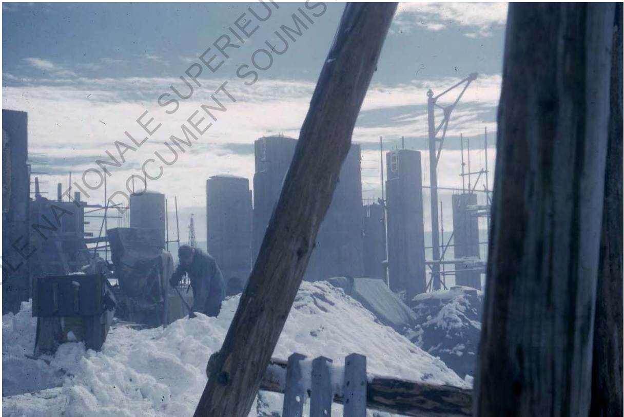
Photographies de chantier par Pierre Debeaux – Année 1960 Archives de Haute-Garonne à Toulouse
