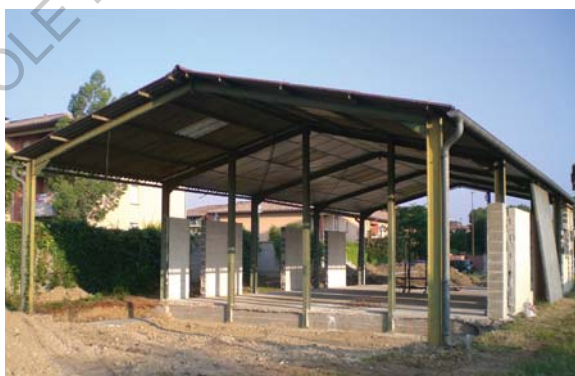
La structure existante conservée pour le projet photo fournie par les propriétaires
