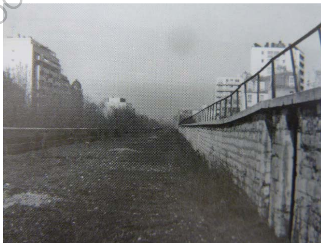
La partie supérieure des arcades en friche après la désaffectation. https://gartenkunstparis.com/tag/promenade-plantee/
