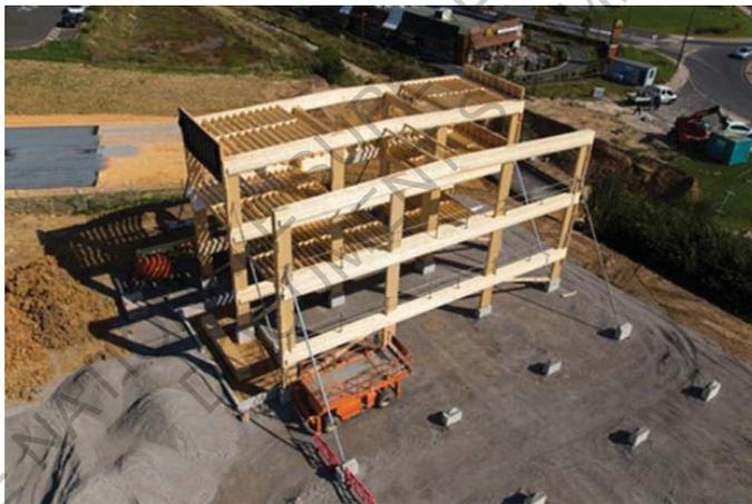
Fig. 22 : Assemblage des modules préfabriqués.
