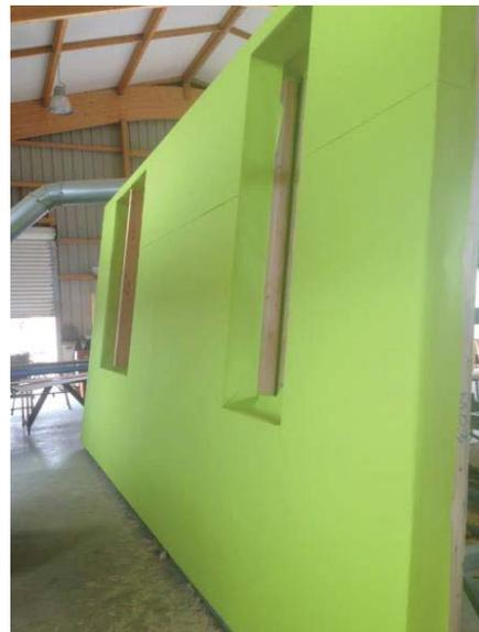
Fig. 29 : Réalisation des murs extérieurs en usine. ►
