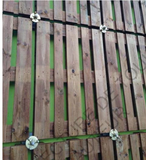
Fig. 30 : Système d'assemblage des palettes.
