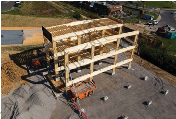
Fig. 22 : Assemblage des modules préfabriqués.
