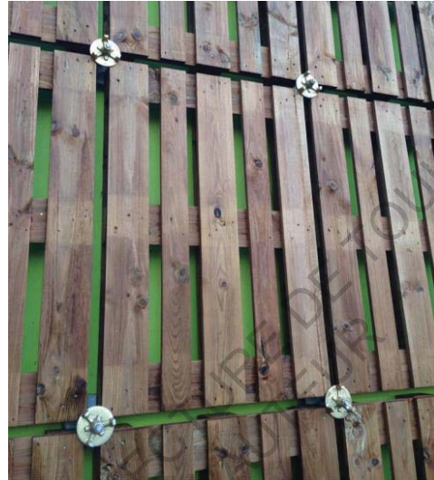
Fig. 30 : Système d'assemblage des palettes.
