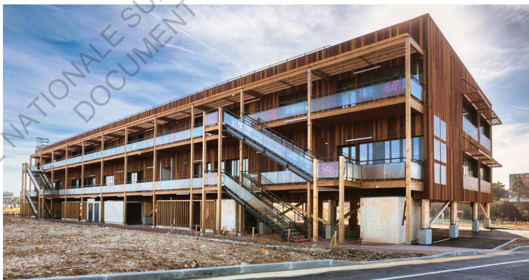
Fig. 20 : Façade nord du bâtiment réalisé.
