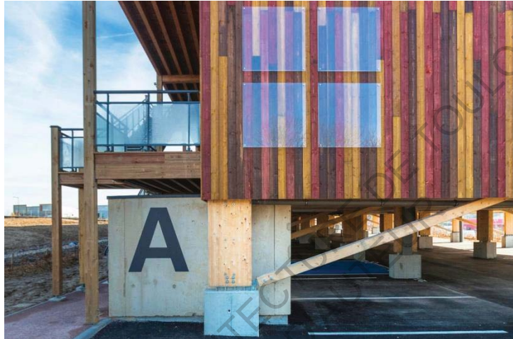
Fig. 21 : Structure sur pilotis et aménagement des places de stationnement.
