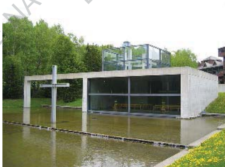
Image 8 – Photo de l'église sur l'eau vue de façade
