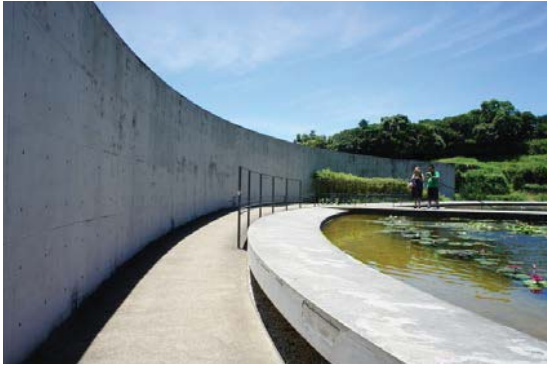
Image 91 : Photo du passage entre le mur et plan d'eau avant l'entrée dans le temple (point F)
