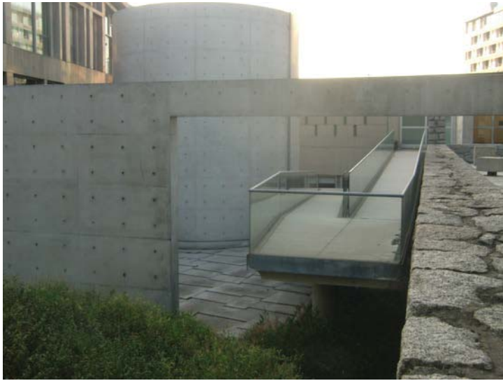
Image 107 : Photo de la rampe d'accès vue de l'extérieur
