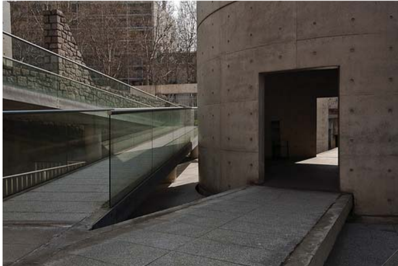
Image 140 : photo rampe qui attire différent niveau
