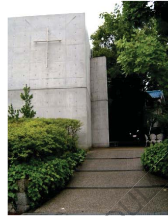
Image 78 : Photo de l'escalier d'accès à l'église de la lumière (point D)
