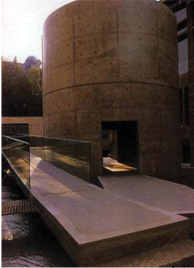
Image 136 : photo en béton la résultat le projet après caresse d'Ando TADAO les murs
