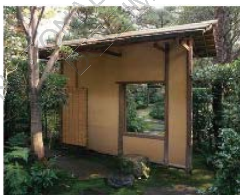
Image 33 – Photo d'un espace de spiritualité composé d'un mur et d'une fenêtre
