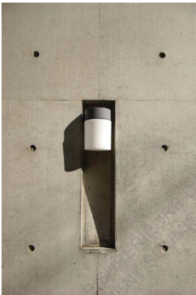
Image 130 : photo le béton de panneaux de coffrage (1m de longueur, 60 cm de largeur) et fixés
