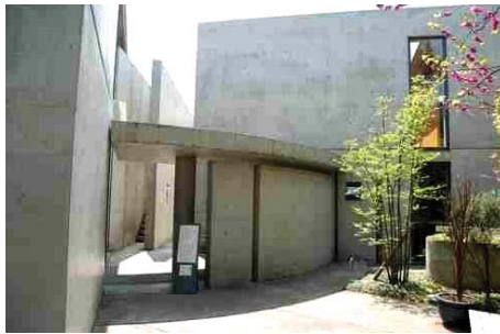
Image 79 : photo de la rampe d'accès à l'entrée principale de l'église de la lumière
