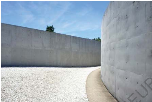
Image 90 : Photo de la marche extérieure d'accès au milieu des murs (point D)
